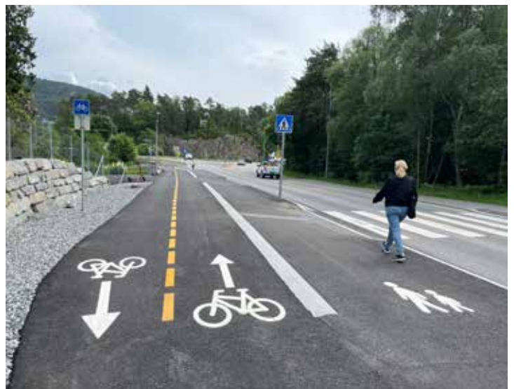
Ny sykkelveg langs nyetablert kollektivfelt i Allestadvegen stod klar i 2023. Foto: Anders Kjetland
