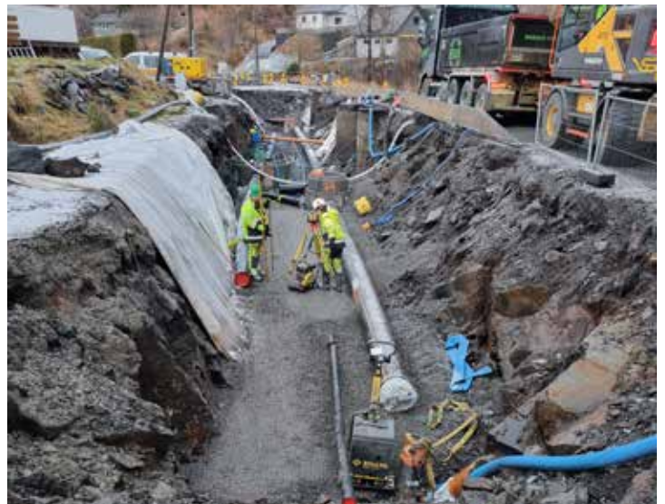
Byggearbeidet i Kvernhusdalen startet opp i november 2023. Foto: Bjarne Nesse
