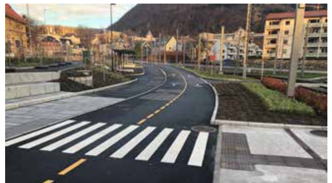
Siste del av sykkelstamvegen mellom Kristianborg og sentrum har kommet på plass. Foto: Statens vegvesen
